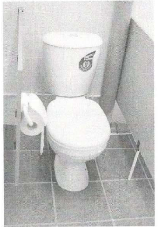
Фото № 19 Туалетная комната
