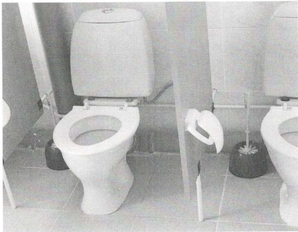
Фото № 20 Туалетная комната
