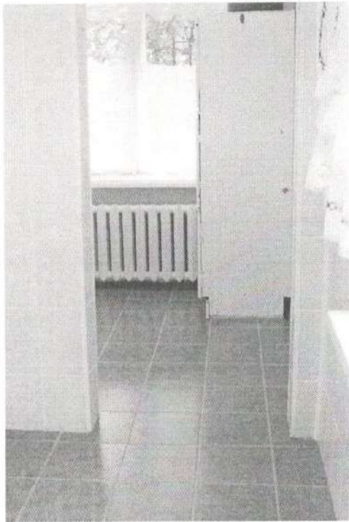
Фото № 18 Вход в туалетную комнату
